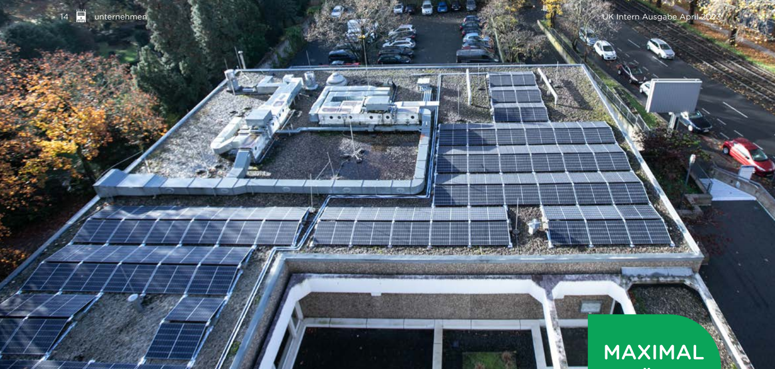
Photovoltaik-Anlage auf dem Dach der Rechtsmedizin
