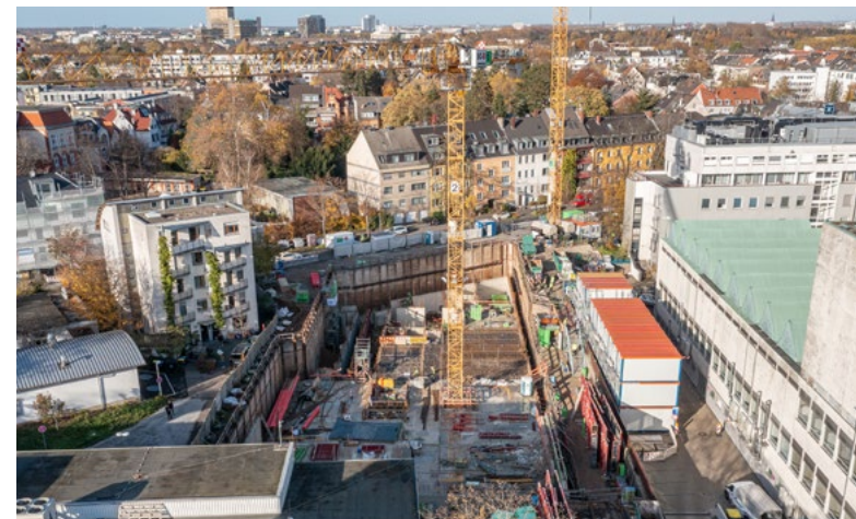
Die Baustelle aus der Vogelperspektive
